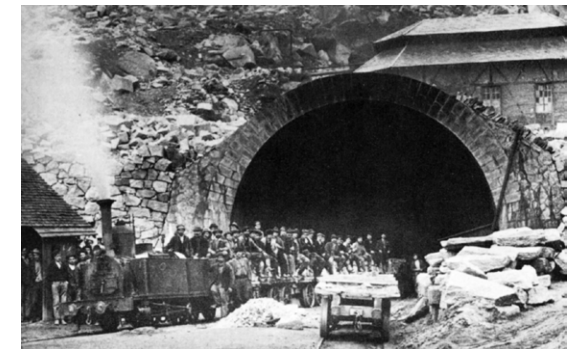
Bau des Gotthard-Tunnels, 1880.
